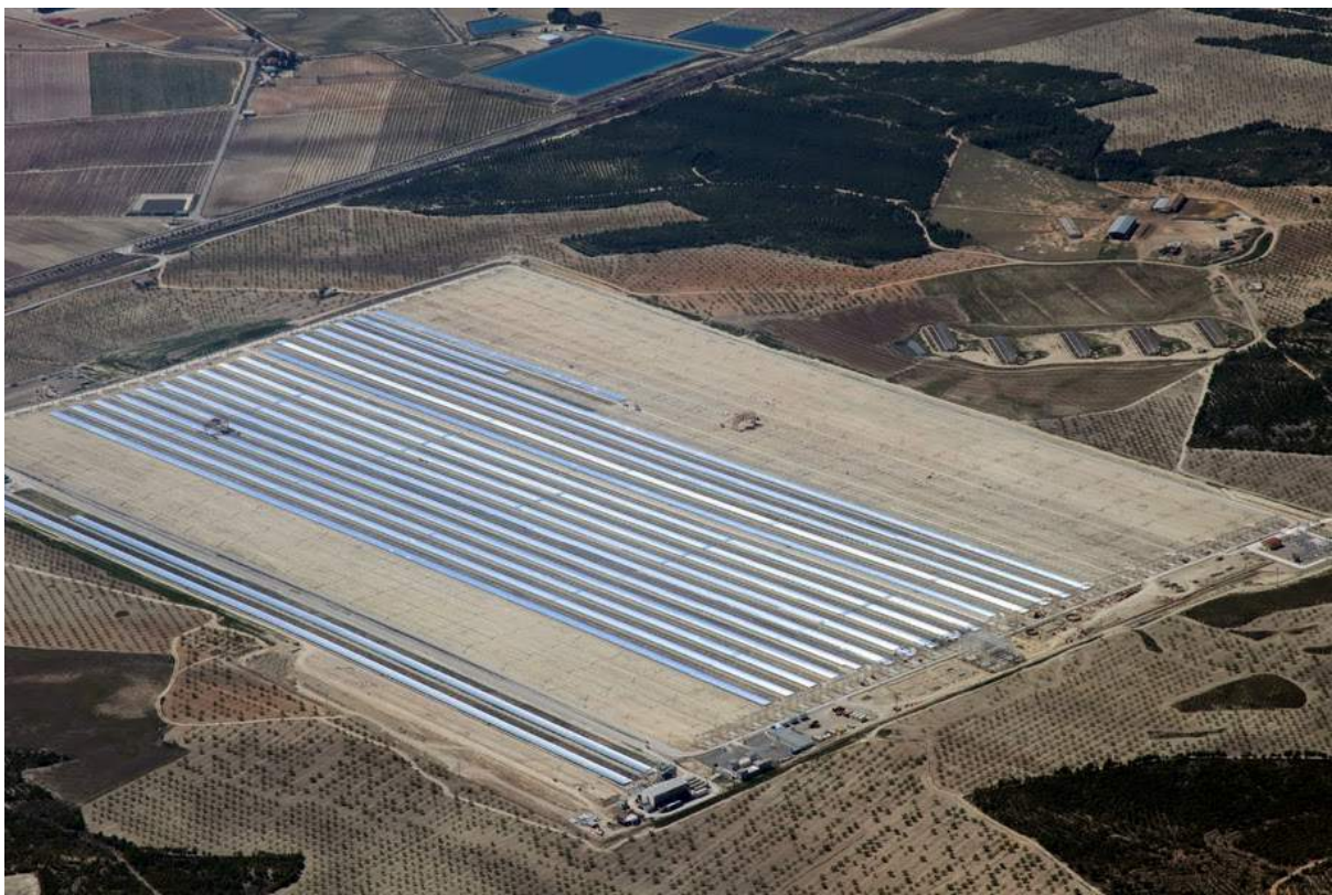
30 MW el solarthermisches Kraftwerk PE 2 im Bau (Bild: NOVATEC SOLAR)
