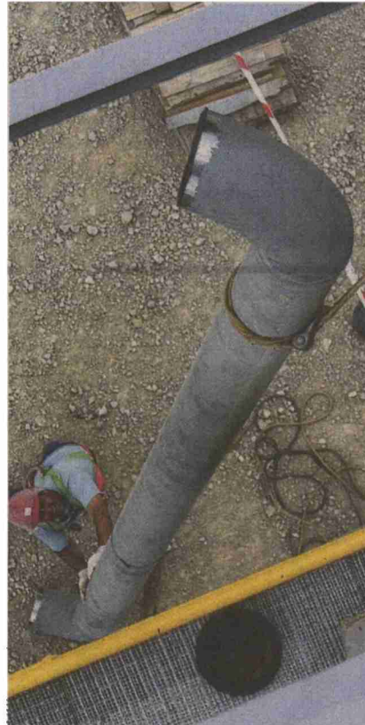
Derzeit werden die Einspeiseleitungen installiert.
